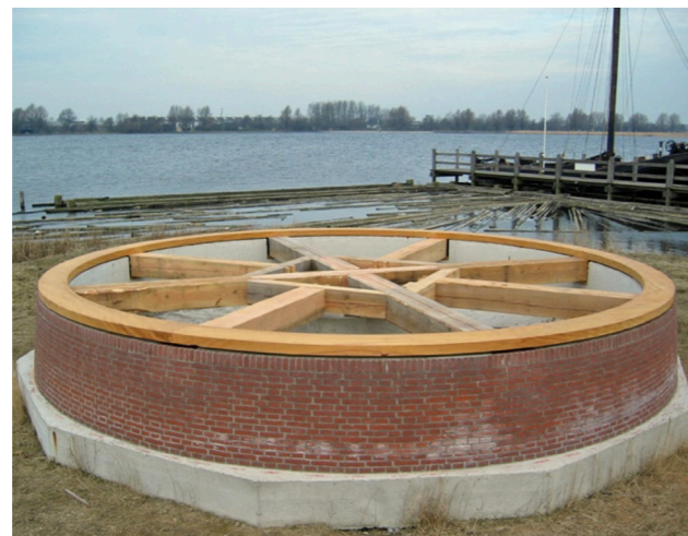
Het moleneiland met de reeds gerealiseerde ringmuur
